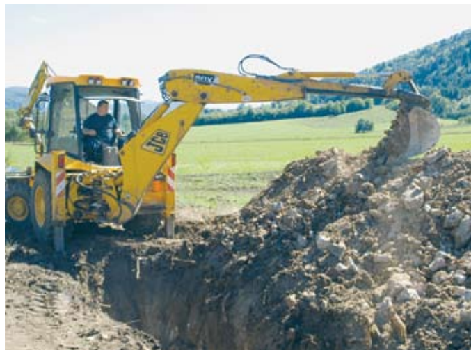
Pri kraju su radovi na kanalizacijskom i vodovodnom sustavu za Gornje Vrhovine
